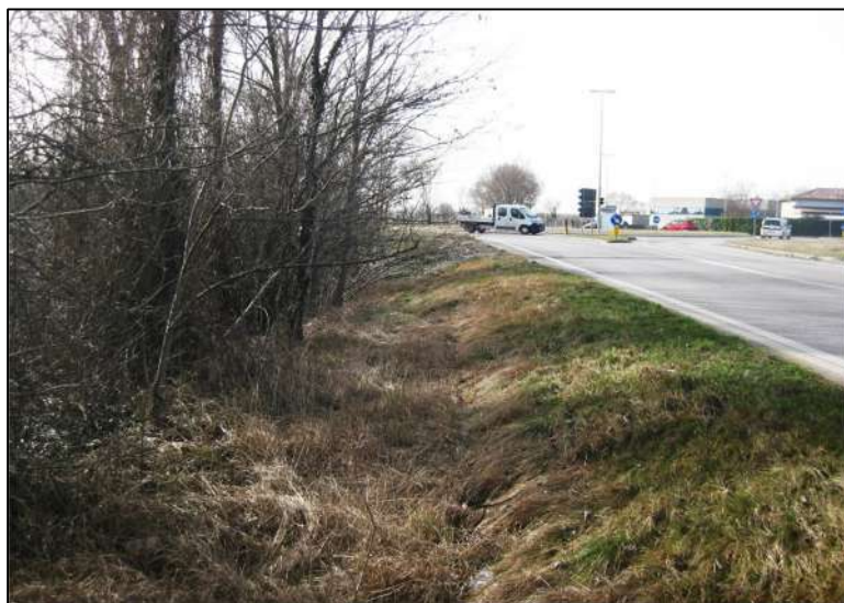
Carreggiata stradale, fosso e formazione arboreo arbustiva nella condizione attuale
